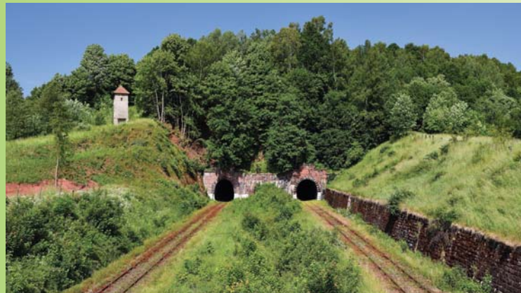
Tunel kolejowy - Świerki. Fot. JeuNasKrasne
