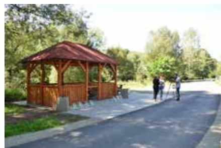
Ścieżka rowerowa we Włodowicach z infrastrukturą. Fot. B. Adamska
